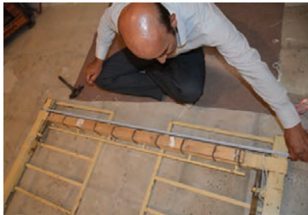
شکل ۱۶-۵ - نصب چوب پایین کشی پشت زیردار
